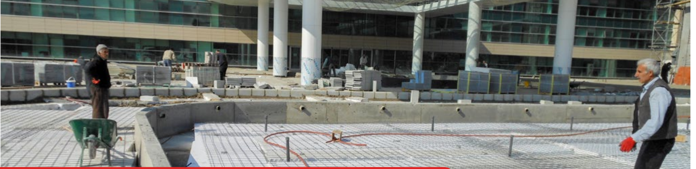
MEDİPOL HASTANESİ, BAĞCILAR-İSTANBUL OTOYOL ÜZERİ HAFİF DOLGU UYGULAMASI
